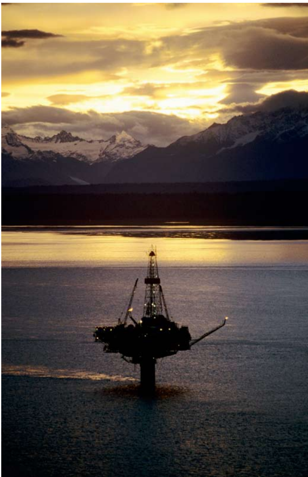
Plate-forme pétrolière en mer, Alaska, USA
